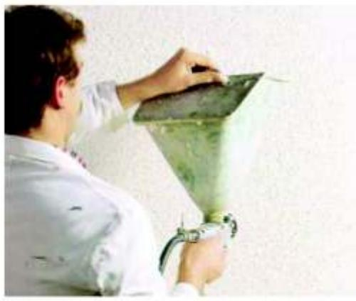
**Штукатурка наносится на поверхность шпателем либо штукатурным пистолетом. Окончательный рельеф поверхности придается рельефным валиком или шпателем примерно через 30-40 мин после нанесения (высыхание “на отлив”)**
