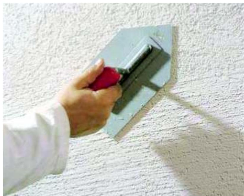
“Затереть” штукатурку следует примерно через 30-40 минут после нанесения на стену. Время высыхания “на отлип” зависит от атмосферных условий (температура, влажность воздуха и т.п.)
